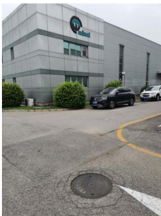
生活废水总排口
