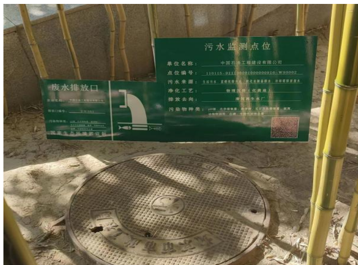
图 5 污水点位（排口的标识牌应固定安装）
