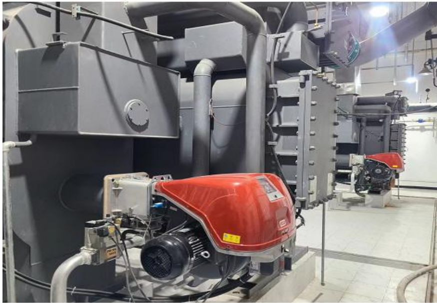
图 6 1号直燃机、2号直燃机
