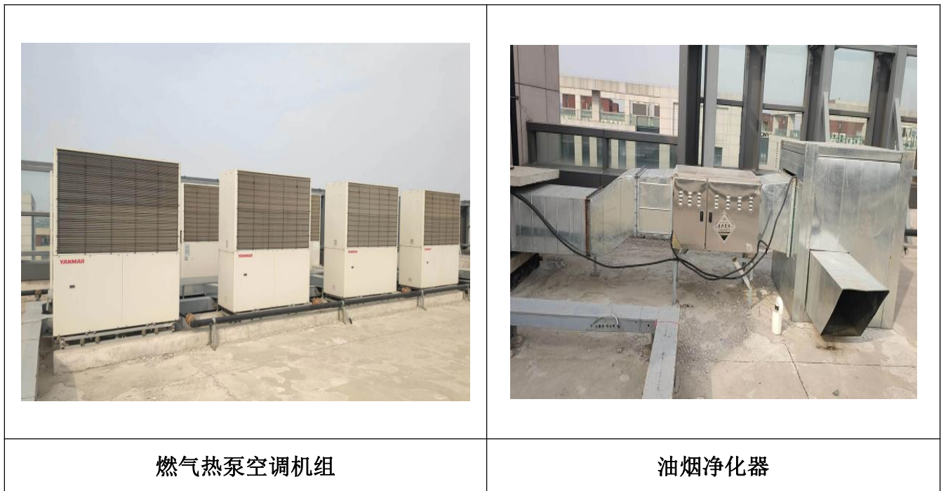
图 6 项目废气设施照片
